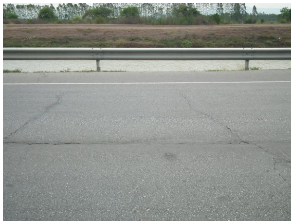
รูปที่ 4.2 รอยแตกเป็นตารางหรือรอยแตกจากการหดตัว
