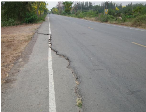
รูปที่ 4.6 การทรุดตัวต่างระดับของไหล่ทาง
